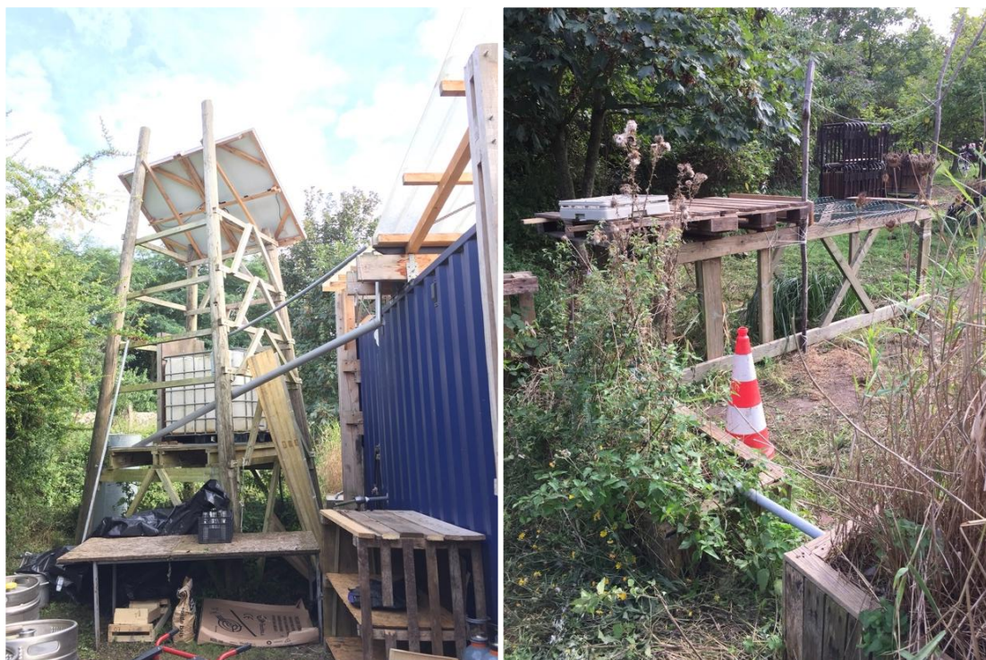
Figure 2 : Système de récupération et de phytoépuration développé par La Facto aux Murs à Pêches
